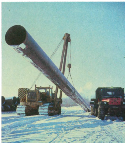
Идет укладка нефтепровода.
